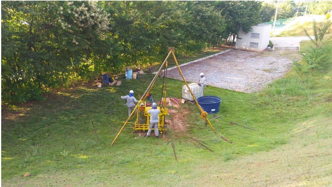
Instalação do furo SM-01
